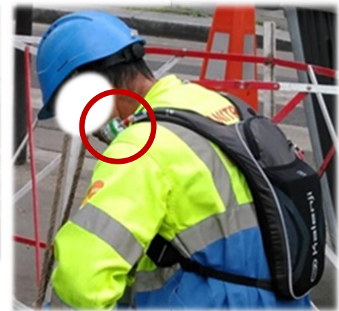
Surveillance d'un tampon d'égout
