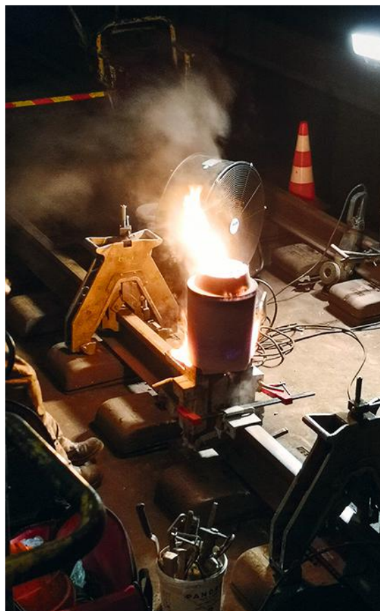
↑ FIGURE 2B Soudage des rails par procédé aluminothermique.
