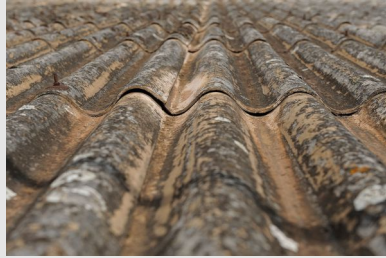
Toiture amiantée en fibrociment
