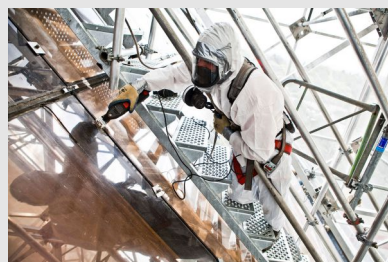
Travail d'un opérateur sur un échafaudage pour le désamiantage d'une verrière
