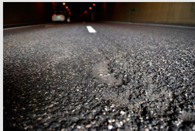
Revêtement goudronné d'une chaussée contenant de l'amiante
