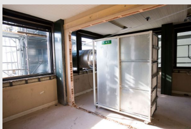
Extracteur d'air à filtration sur un chantier de désamiantage dans un bâtiment
