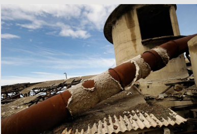
Friche industrielle d'une ancienne usine de transformation d'amiante, avec matériaux amiantés
