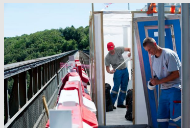
Construction d'une installation de décontamination sur un chantier de désamiantage sur un viaduc
