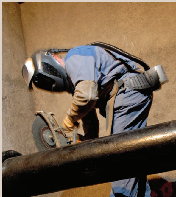
Découpe d'un tuyau dans une chambre à vannes reliée au réseau d'eau potable.
