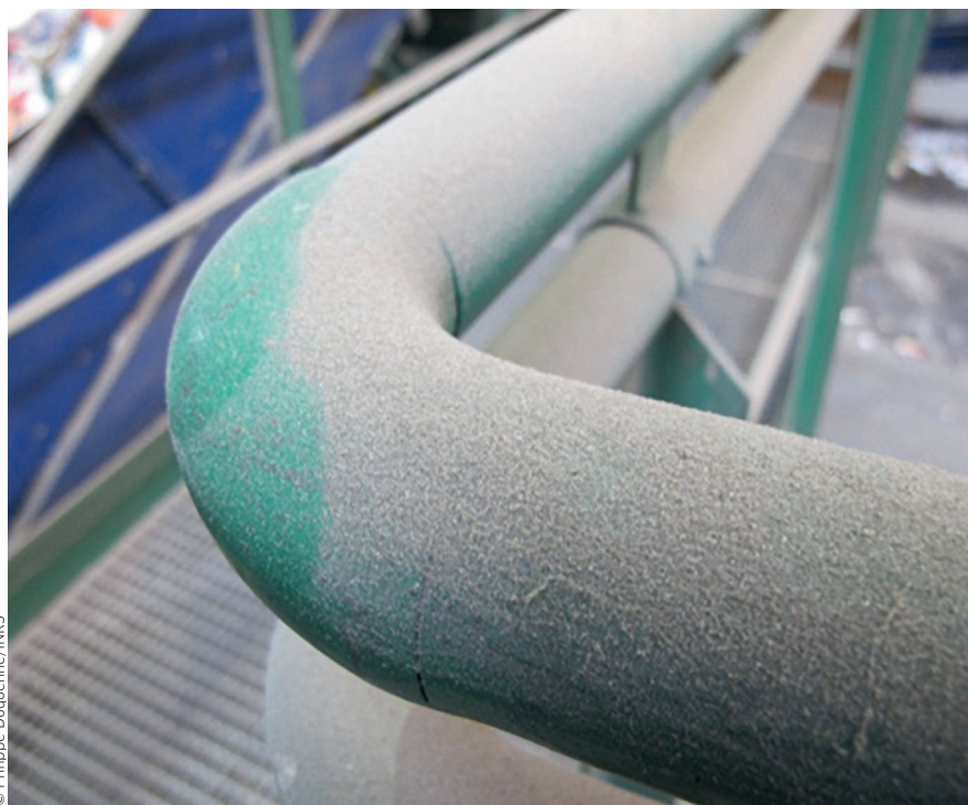
↑ FIGURE 4 Exemple illustrant les poussières déposées sur les installations de tri : ici une main-courante.
