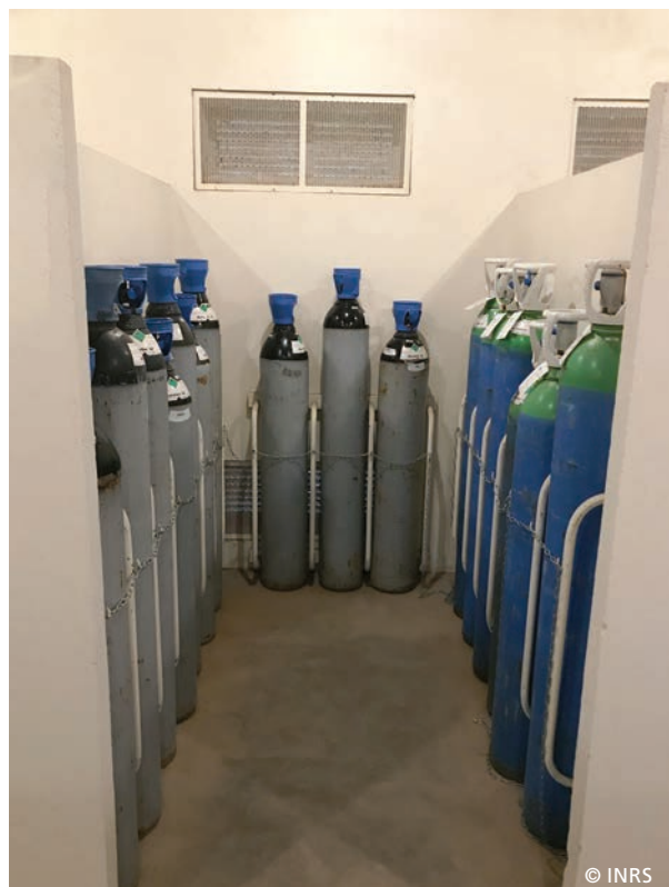
Figure 11. Exemple d'aménagement de stockage des bouteilles de gaz en stockage centralisé
