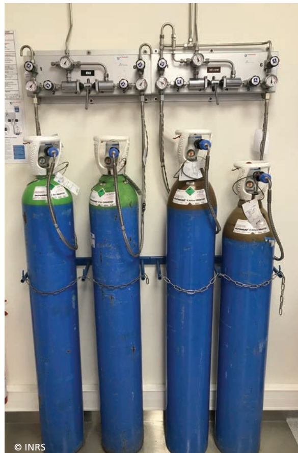
Figure 15. Bouteilles raccordées au réseau
