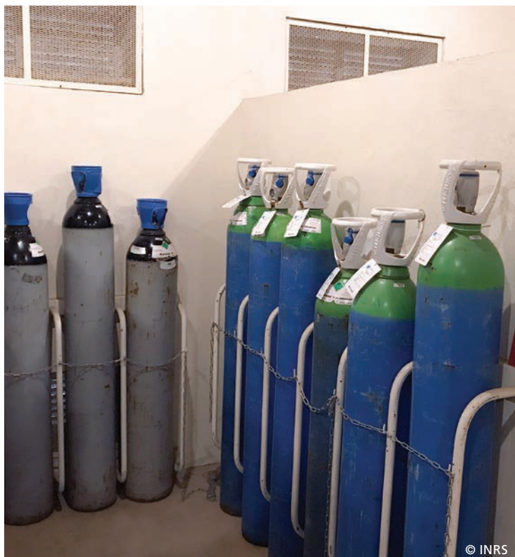
Figure 11. Exemple d'aménagement de stockage des bouteilles de gaz en stockage centralisé
