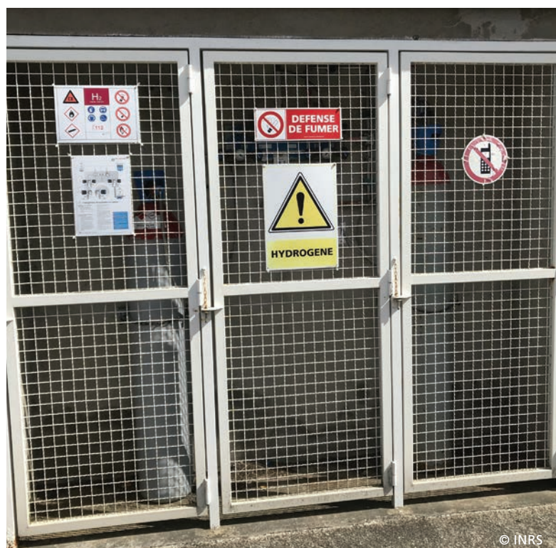
Figure 10. Exemples de signalisation de la zone de stockage de bouteilles de gaz
