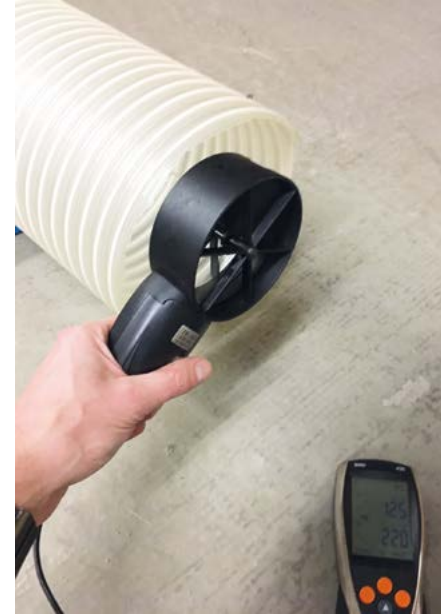
Exemple : mesure en sortie de conduit souple au refoulement d'un extracteur
