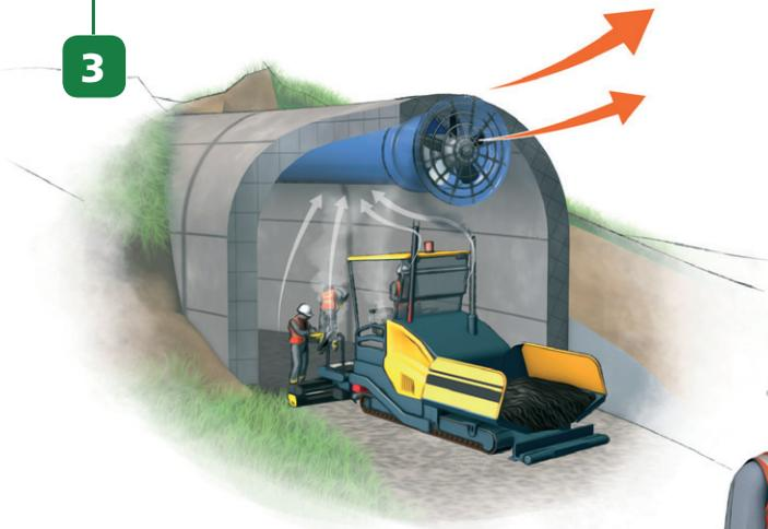
Les systèmes de ventilation limitent l'accumulation des fumées de bitume sur un chantier du type parking souterrain ou parking couvert, tunnel, tranchée couverte... Ils limitent aussi le besoin de porter des appareils de protection respiratoire.
