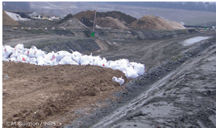
Casier amiante en cours d'exploitation. Recouvrement à l'avancée
