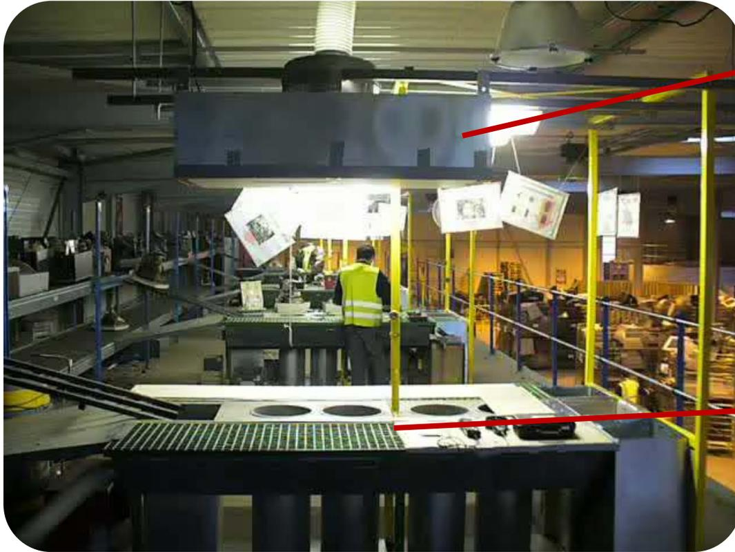
**Plénum (1200x700x300 mm)** : diffuseur laminaire avec double paroi perforée
