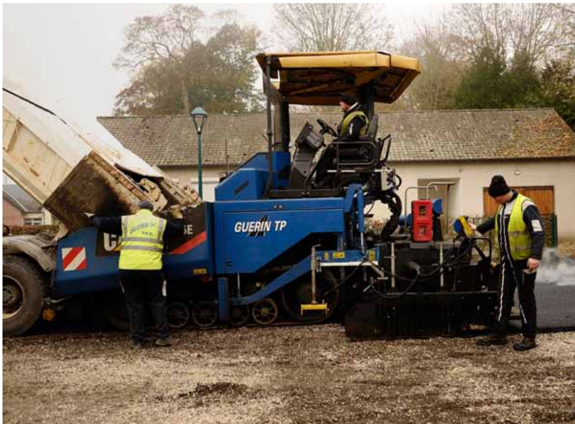
Finisseur: engin de chantier utilisé pour épandre uniformément et pré-compacter le revêtement bitumineux.
