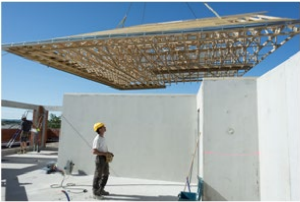
Charpente bois préfabriquée
