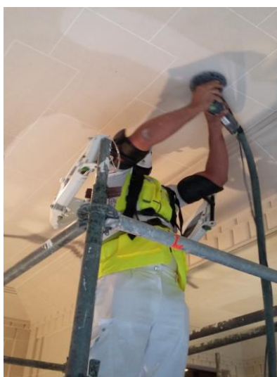
Figure 36. Dispositifs d'assistance proposés par Exhaus® (©INRS/STUC & STAFF)
