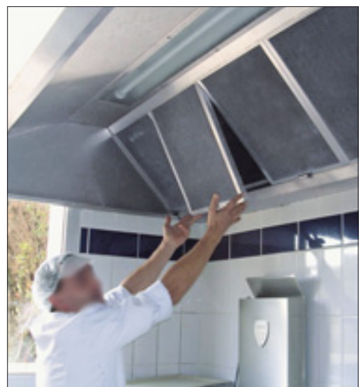
Démontage de plain-pied d'un filtre de hotte.
