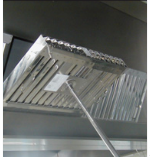
Outil de démontage/remontage du filtre en position.
