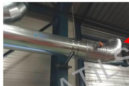
Clapet d'équilibrage : Entrée d'air additionnelle
