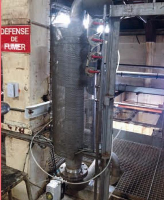
Figure 21. Grille rigide évitant tout contact avec une canalisation chaude
