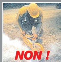
Les opérations d'usinage, découpe, perçage, dépose libèrent des fibres d'amiante invisibles à l'œil nu.
