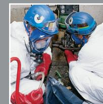
Limitez l'émission de poussières en humidifiant, en utilisant des outils à vitesse de coupe lente, en aspirant à la source avec un aspirateur à très haute efficacité THE et en protégeant la zone de travail.
