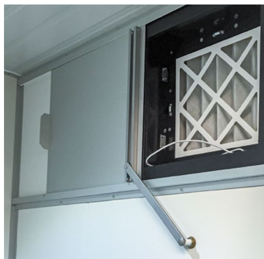
Figure 4. Exemple d'obturateur coulissant devant un extracteur
