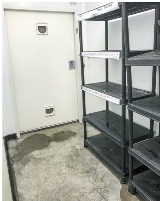
■ Figure 32. Écluse « sortie matériel » avec étagère de rangement
