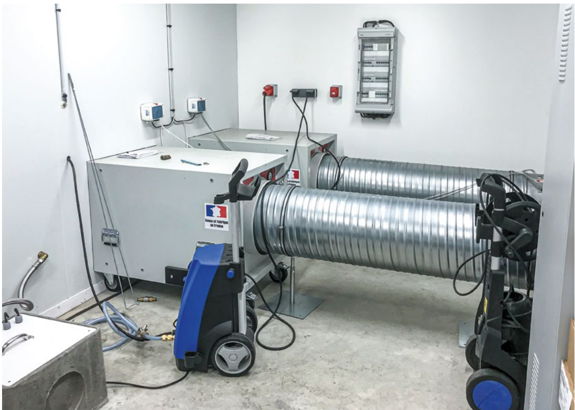
■ Figure 8. Filtration de l'air issu de l'unité de traitement avec deux extracteurs de classe H, dont un de secours
