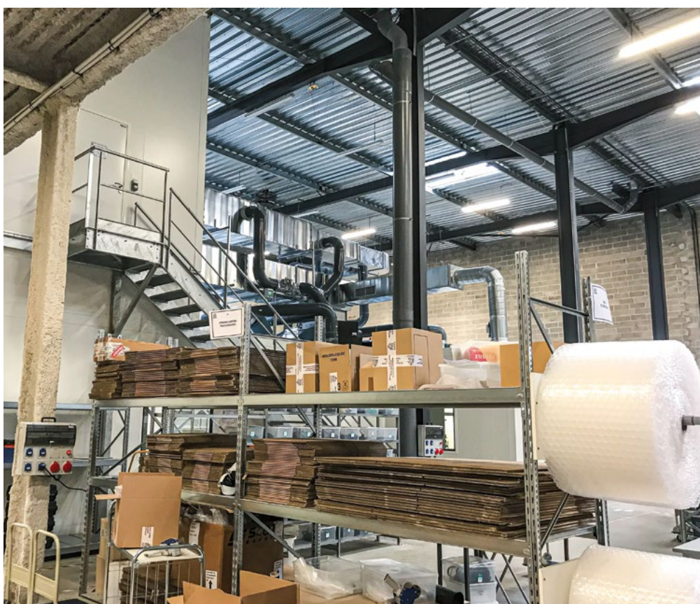
■ Figure 34. Zone de remballage du matériel après décontamination et maintenance ; dispositif centralisé de traitement de l'air issu de l'unité de traitement avec rejet à l'extérieur du bâtiment
