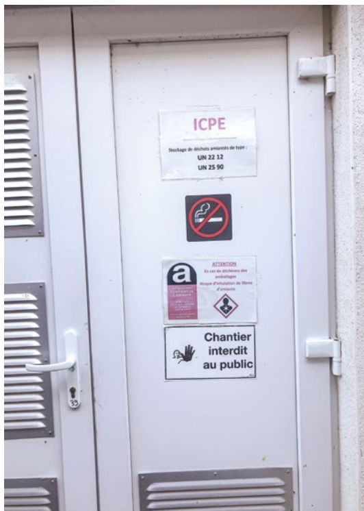
■ Figure 37. Local « déchets amiante » dédié, fermé, permettant l'entreposage des déchets à l'abri des UV et des intempéries
