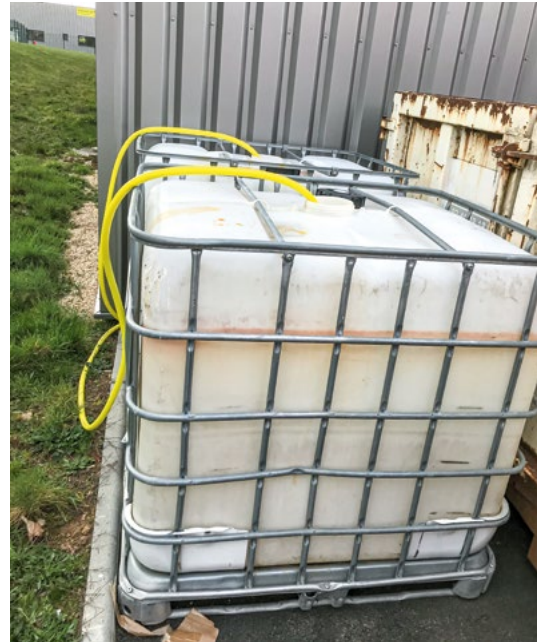
Figure 11. Stockage des eaux filtrées en attendant des résultats d'analyse MEST en vue de leur rejet
