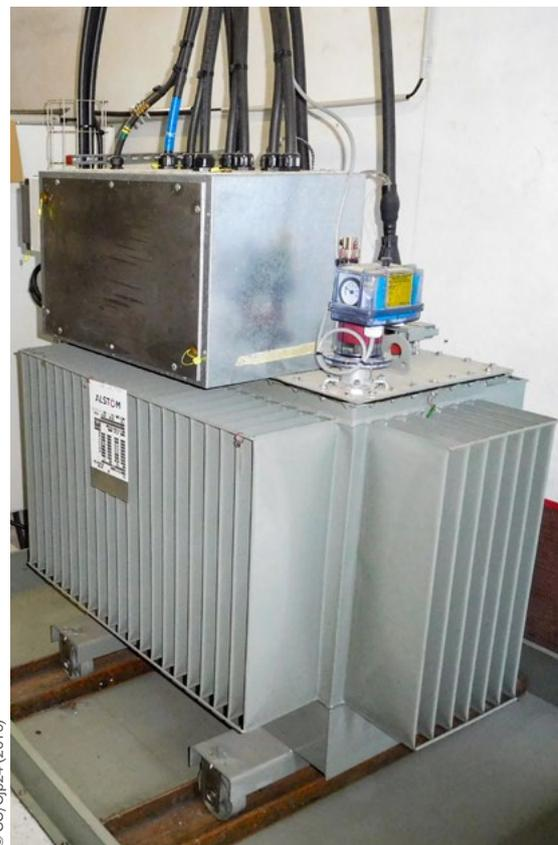
■ Transformateur à haute tension/basse tension.
