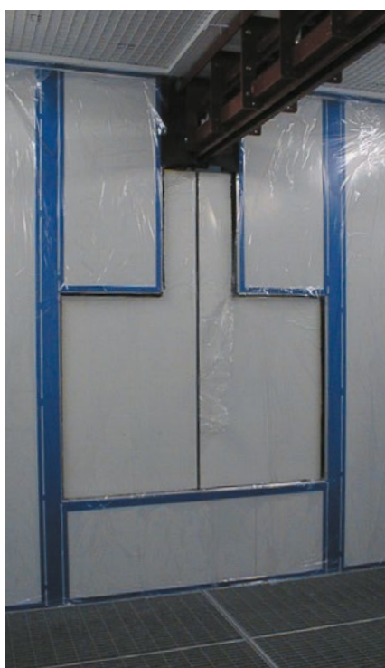
Portes coulissantes permettant l'entrée des subjectiles convoyés dans une cabine fermée à ventilation verticale.
