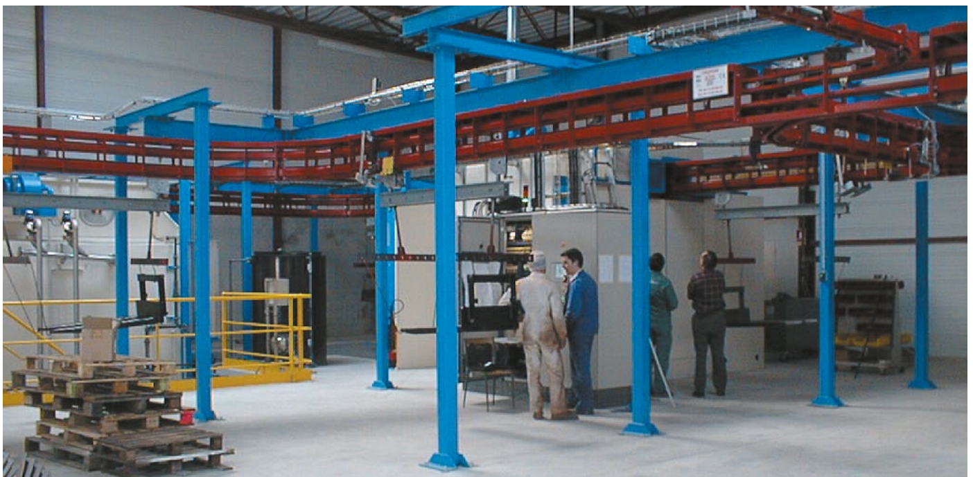
Vue d'un atelier abritant une cabine de poudrage et son convoyeur.
