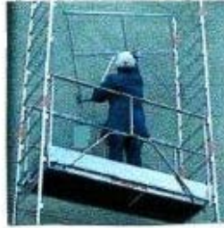
Mise en place des garde-corps La fixation des garde-corps est impérative pour passer à l'étape suivante. L'ordre de montage est bien défini.
