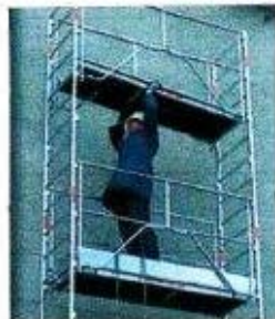
Mise en place du plancher Une fois le plancher fixé, il est absolument impossible d'enlever les garde-corps. C'est le principe du montage et démontage en sécurité catégorie 1.
