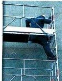
Accès à l'étage supérieur sécurisé
