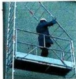
Mise en place des échelles
