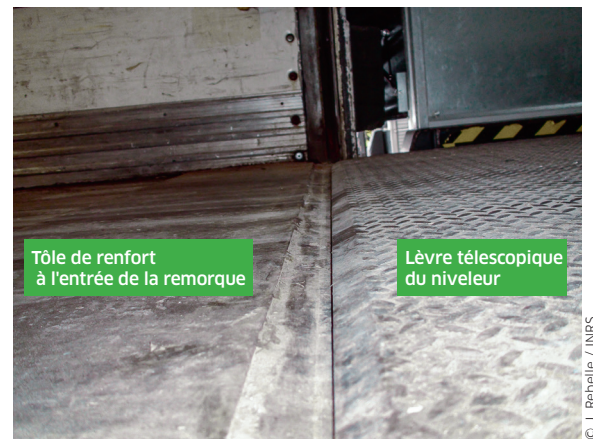
↑FIGURE 7 Zoom sur la gorge formée entre la lèvre du niveleur (à droite) et la plaque de renfort à l'entrée de la remorque (à gauche).
