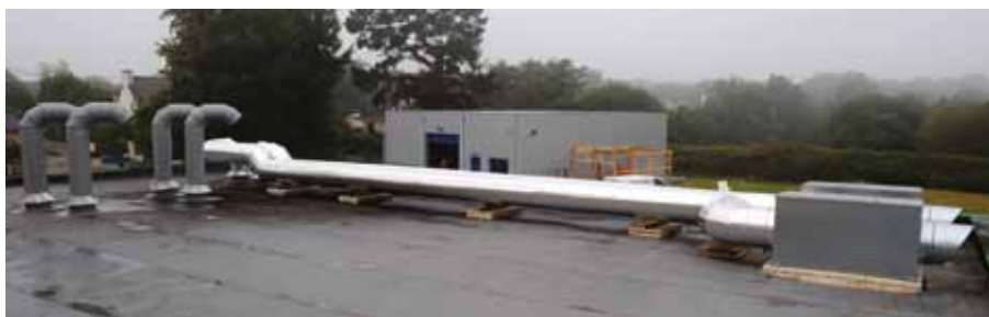
Photo 2. Les centrales de traitement d'air
