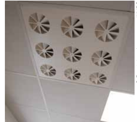
Photo 3. Caissons d'introduction d'air de compensation en salle de macroscopie
