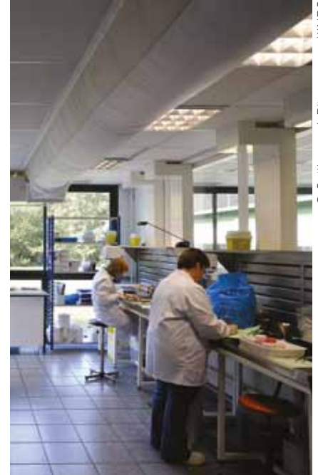
Une gaine de diffusion d'air dans le local de macroscopie
