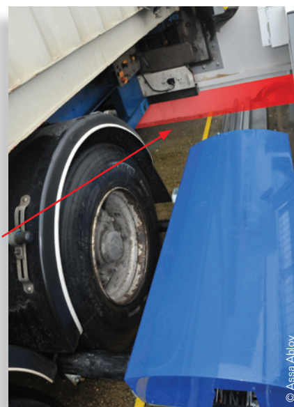
Zone de sécurité contrôlée par le dispositif de détection de présence
