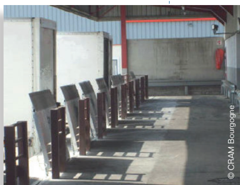
Quai ouvert avec parapet entre chaque pont de liaison
