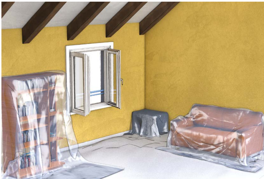
Figure 9. Préparation du chantier avec pose des films plastiques et ventilation naturelle
