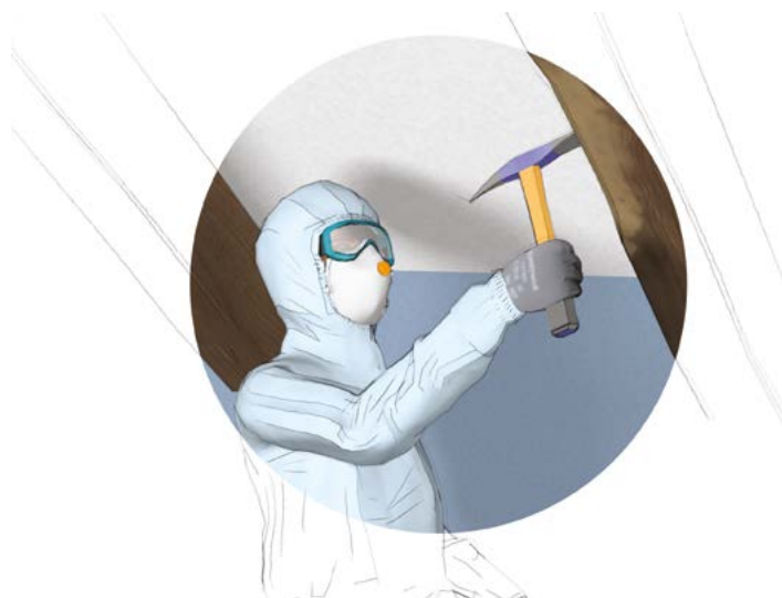
■ Figure 2. Bûchage (durée de port du masque < 1 h)
