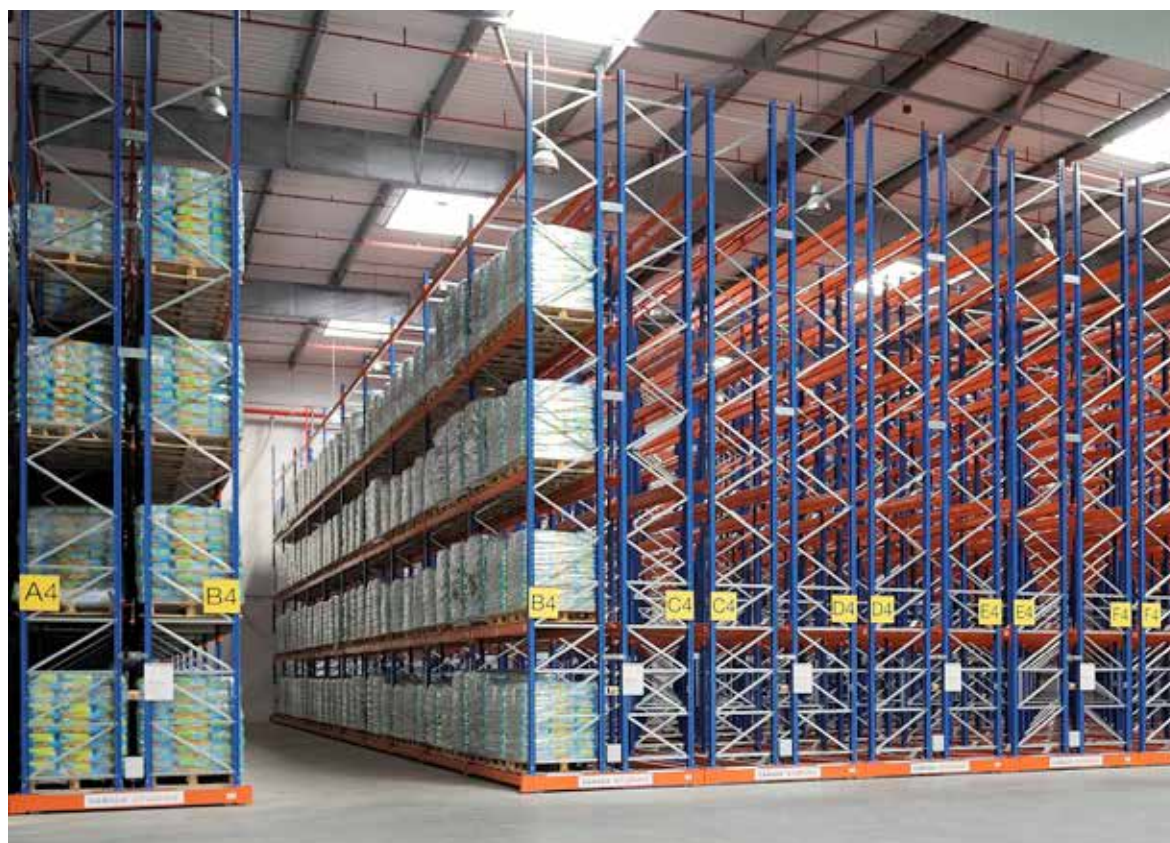
Installation de stockage à rayonnages mobiles
