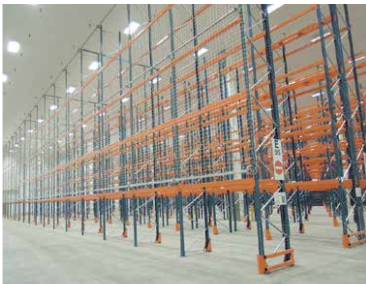
Protection de face arrière par filets
