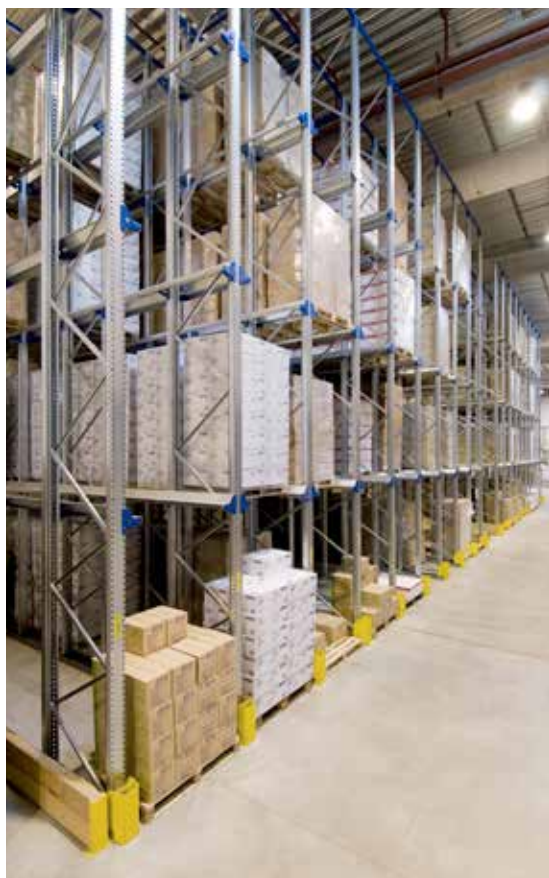
Installation de stockage à accumulation
