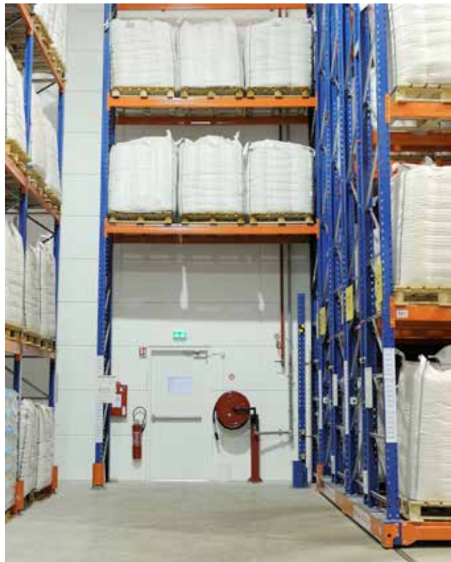
Aménagement de palettier en fonction de l'implantation d'un RIA et d'une issue de secours
