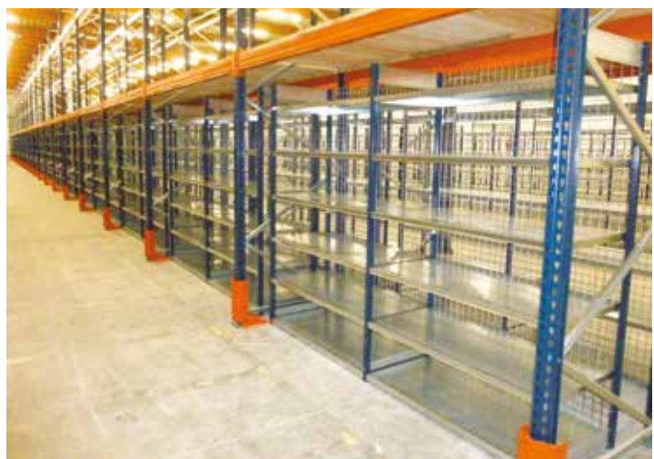
Plancher plein au-dessus d'étagères
