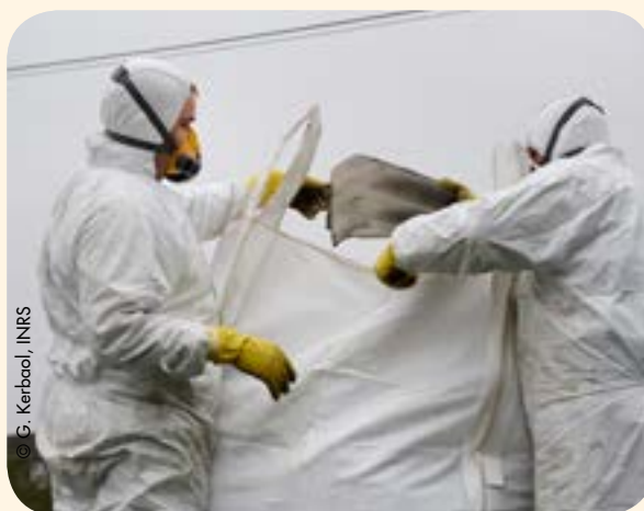
Mise en sac de déchets d'amiante
