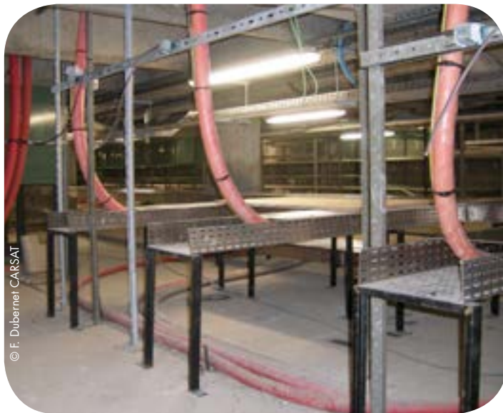
Tirage de câbles dans un environnement pollué
