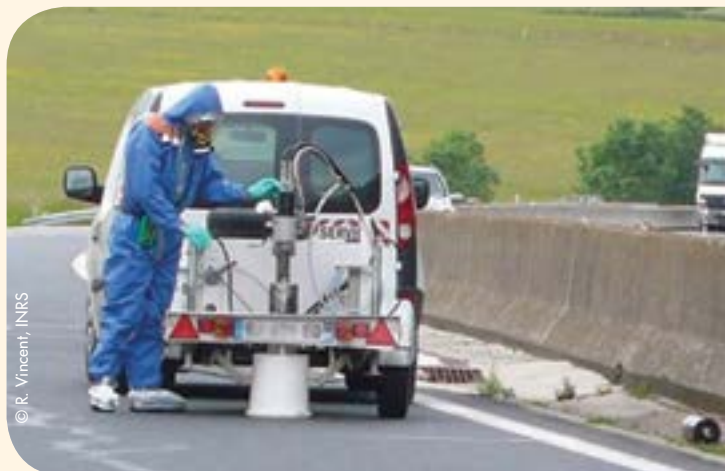
Carottage de chaussée amiantée
