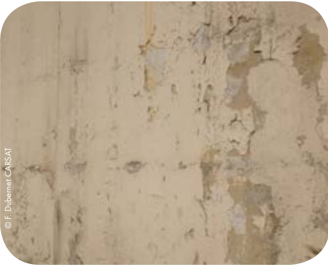
Enduit de façade
