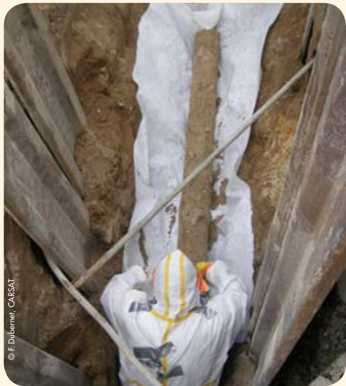
Emballage d'un morceau de canalisation
