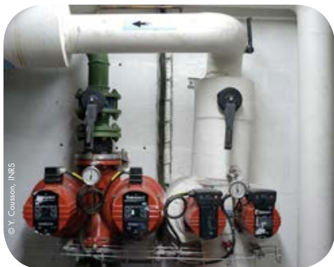
Calorifugeage de conduits
