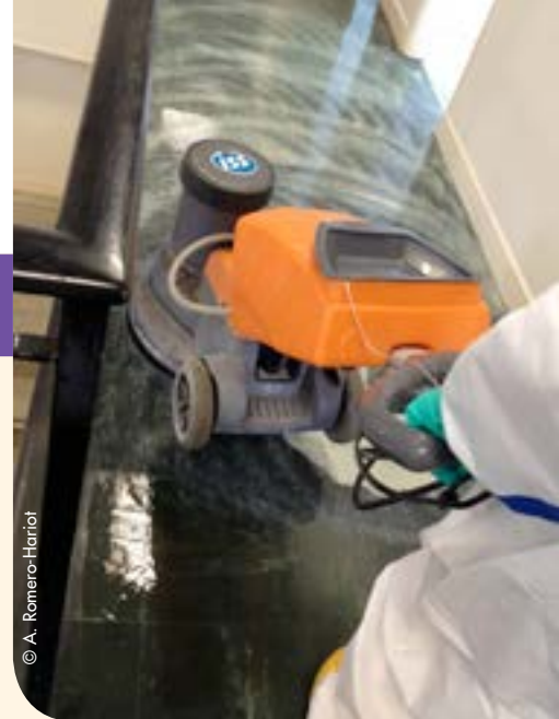
Décapage de dalles amiantées avec mono brosse équipée de disque "noir"
