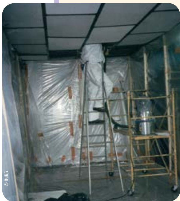
Dégagement d'une dalle de faux-plafond amiantée pour accéder aux poutrelles
