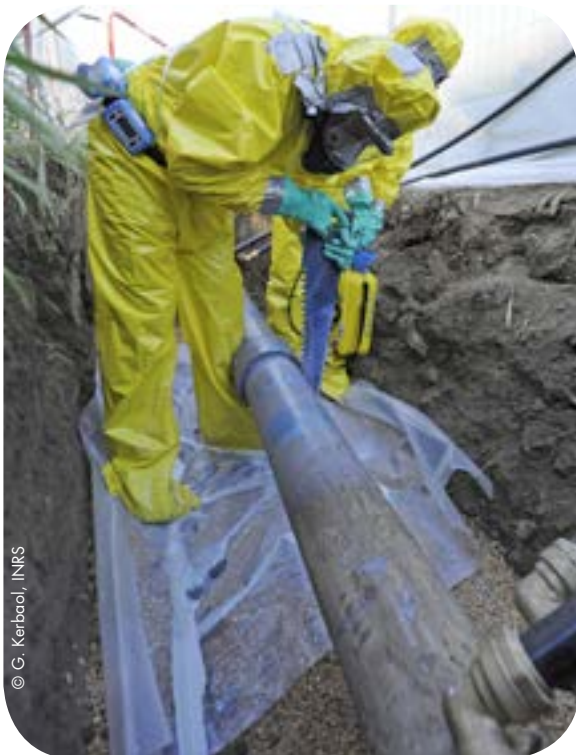
Sciage d'une canalisation à la scie égoïne
