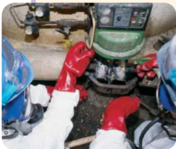
Pulvérisation de la bande à l'aide d'une eau additionnée d'un agent mouillant
