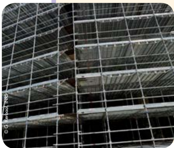
Échafaudage de façade
