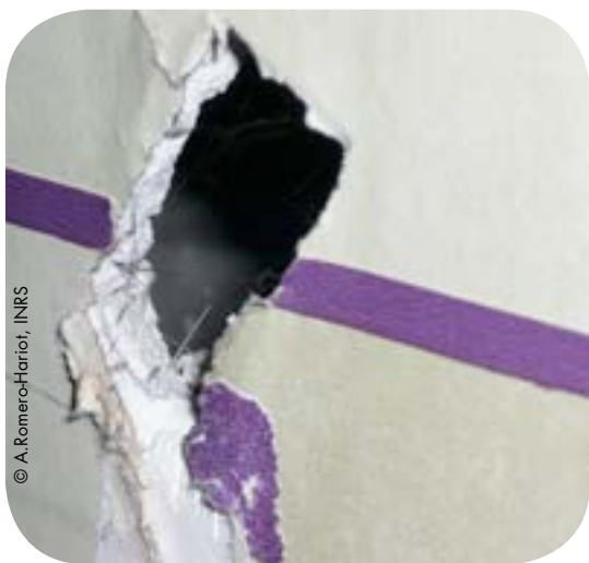
Sondage destructif lors d'un repérage avant travaux
