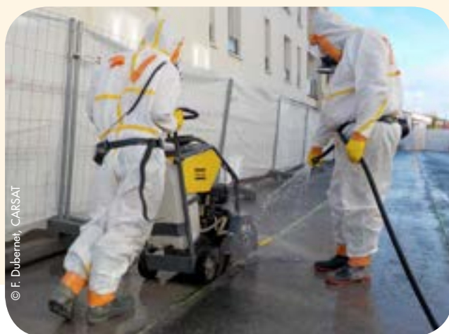
Sciage de chaussée sous arrosage
