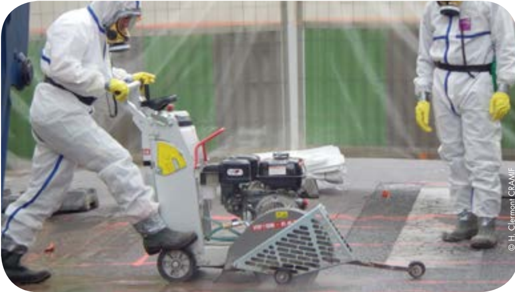
Sciage de chaussée avec arrosage automatique
