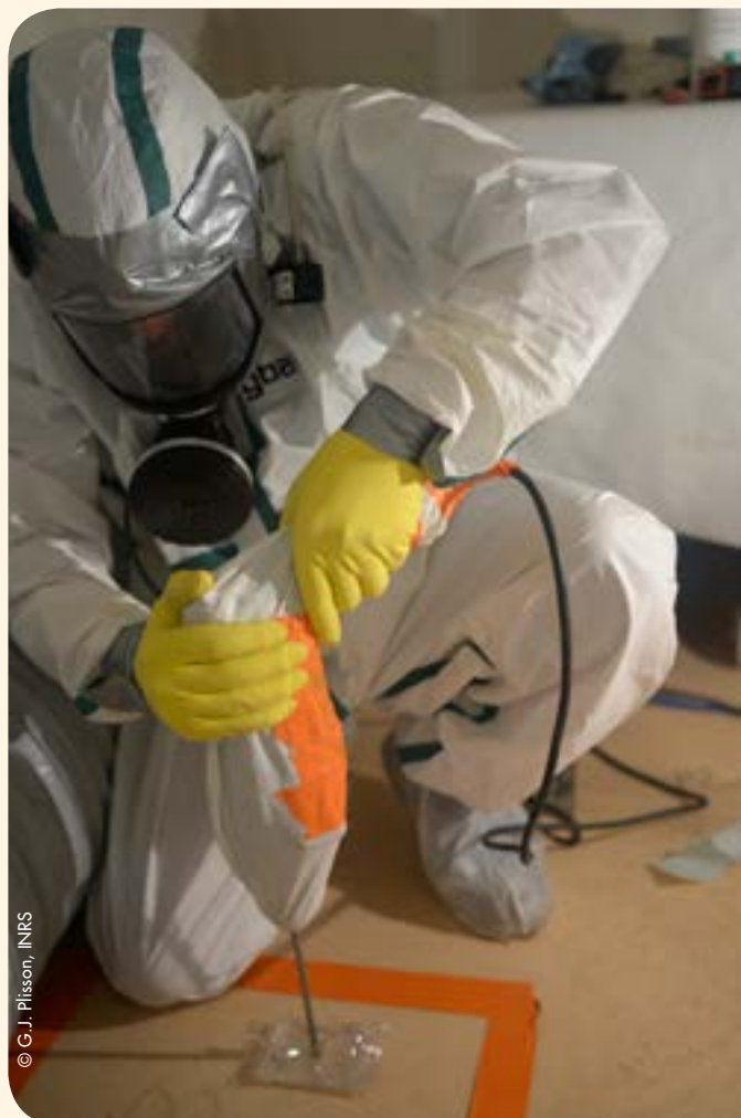
Perçage de dalle amiantée à l'aide d'une poche de gel hydrique
