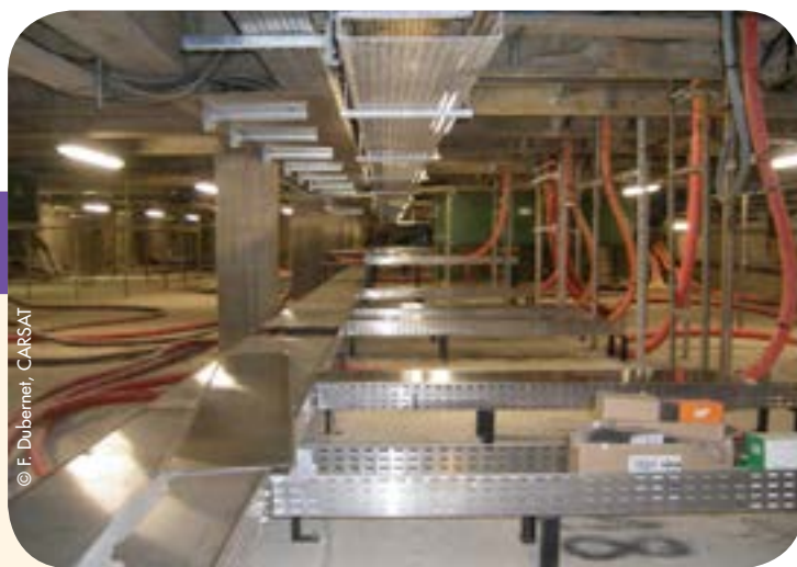
Pose de chemin câble
