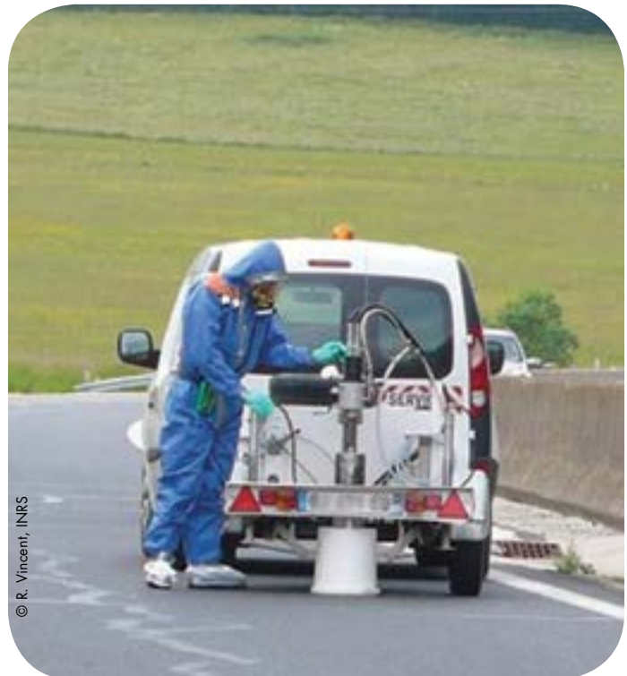
Carottage de chaussée à l'humide
