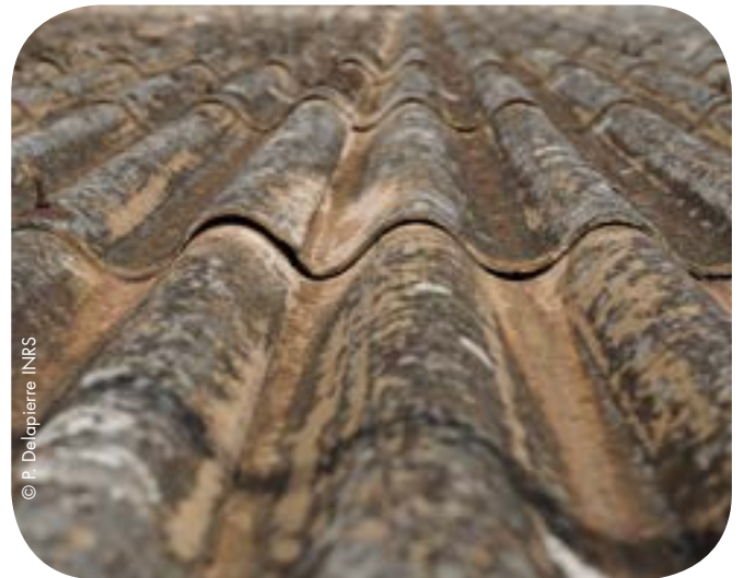
Toitures en amiante-ciment
