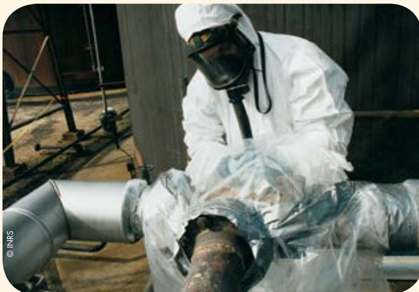
Changement de joint de bride dans sac à manches.
