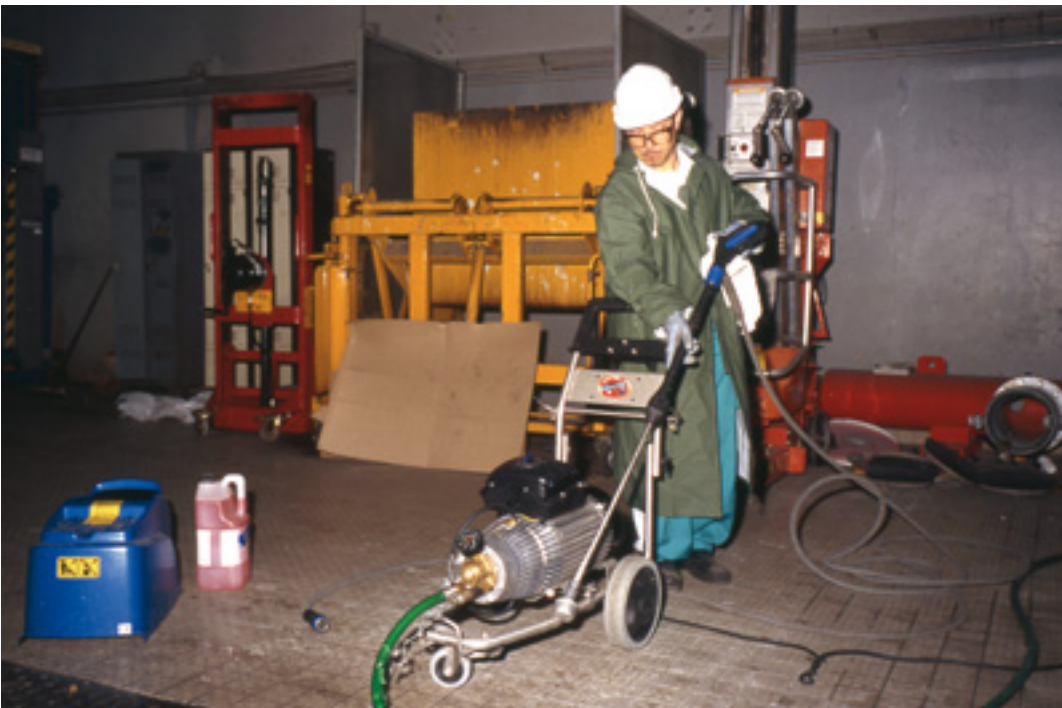
11. Sensibiliser, former les personnels au risque de contamination lors de l'emploi de systèmes de nettoyage à haute ou très haute pression
