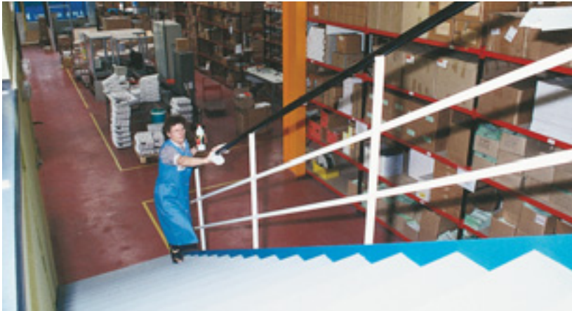
7. Vérifier l'état des escaliers
