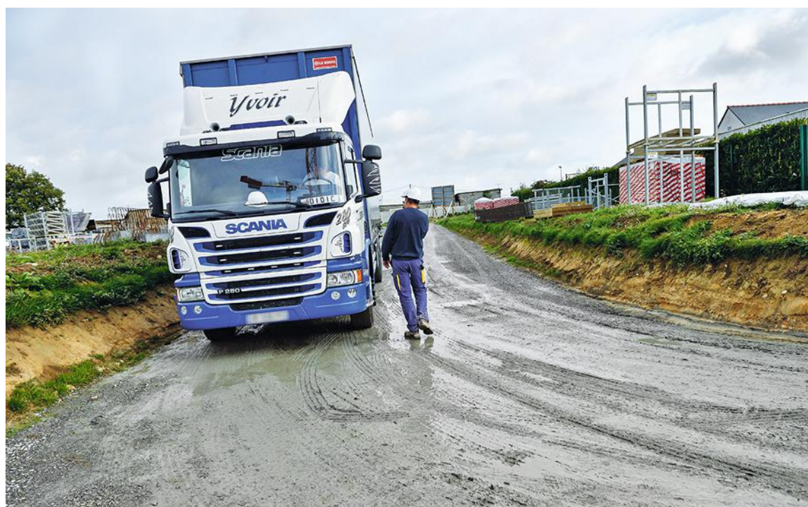
Livraison de matériels sur chantier.
