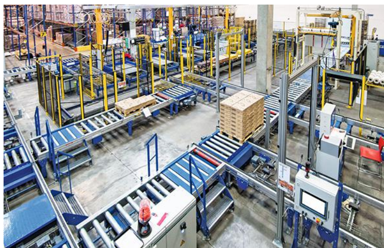
↑ PHOTO 3 Convoyeurs à palettes dotés de passages équipés pour les opérateurs.
