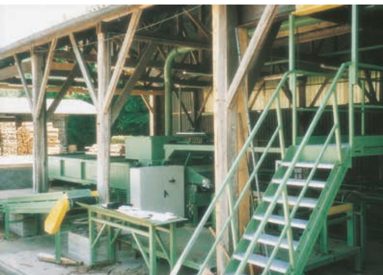
Figure 12. Exemple de passerelle
